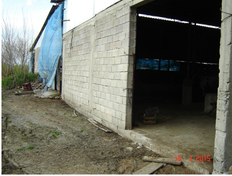
Resim 3. D3 nolu işletme
